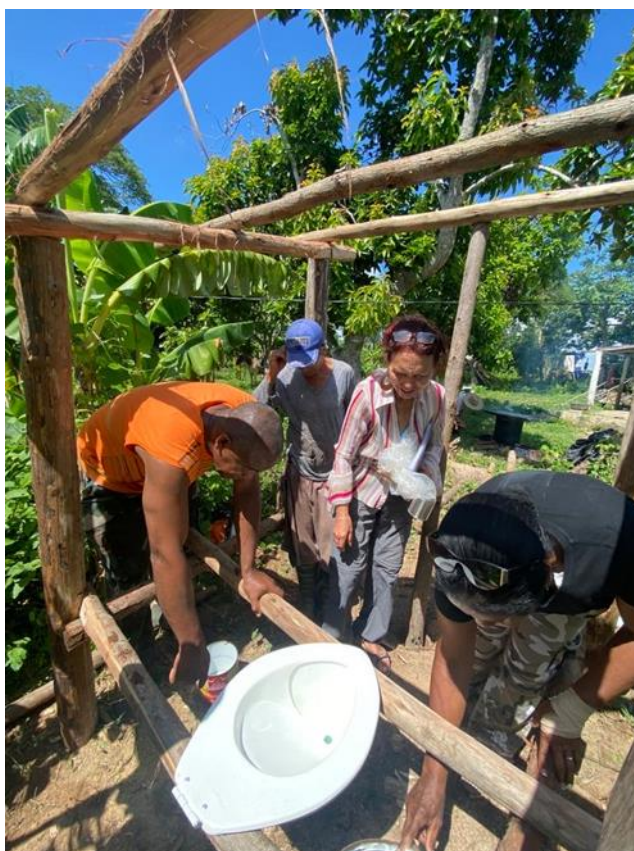
Bau eines Trockenklos Juli 2023 in Consolacion ©EcoMujer Cuba
